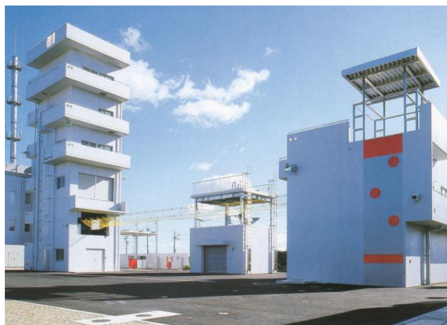
■ 中消防署訓練塔
